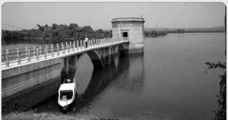
၁၉၄၀ ပြည့်နှစ်က တည်ဆောက်ပြီးခဲ့သော ဂျိုးဖြူရေလှောင်ကန် ရေယူအဆောက်အအုံကို မြင်တွေ့ရစဉ်။
