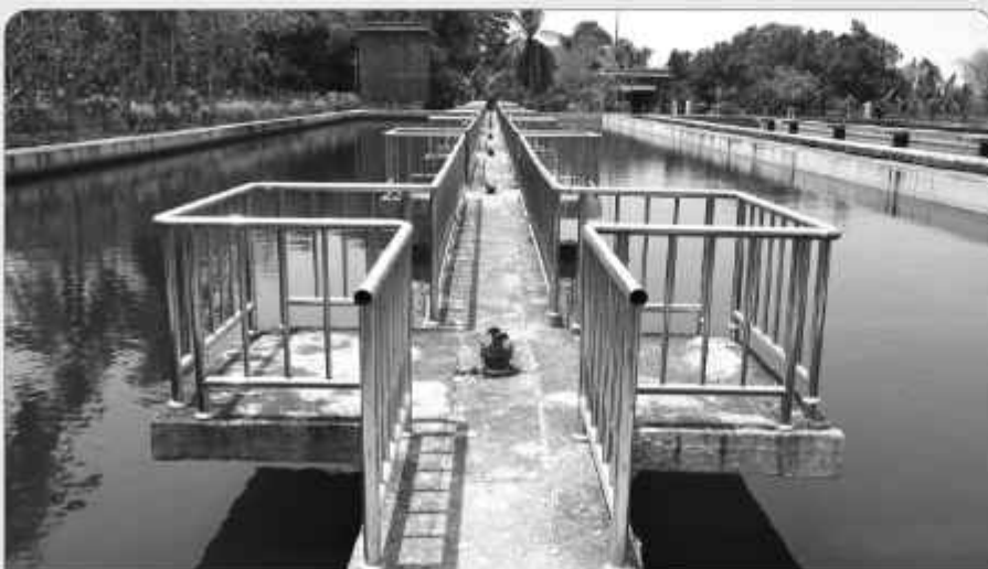
ကျေးဇူးလောင်ကန်ရှိ နောက်ဆုံးရေသန့်စင်မှုလုပ်ငန်းကို မြင်တွေ့ရစဉ်။
